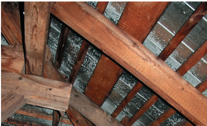
Состояние кровли после капитального ремонта (пос. Металлострой, ул. Пионерская, д. 6/11)
